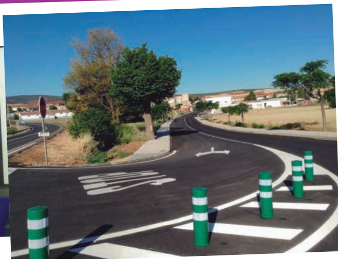
Obras de acceso a Corral de Calatrava por la calle Constitución
