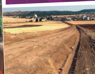
Reparación de caminos
